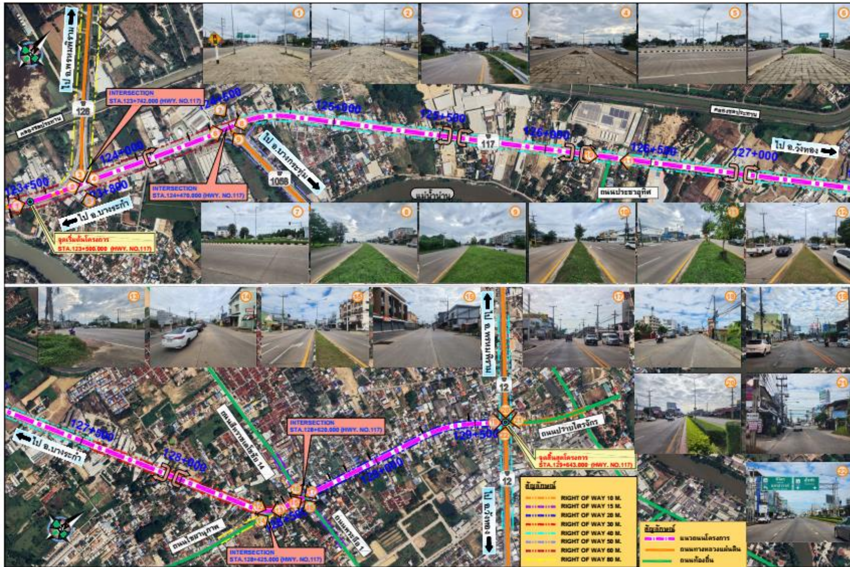
รูปที่ 5.1.1-3 สภาพทั่วไปตามแนวทางหลวงโครงการ
