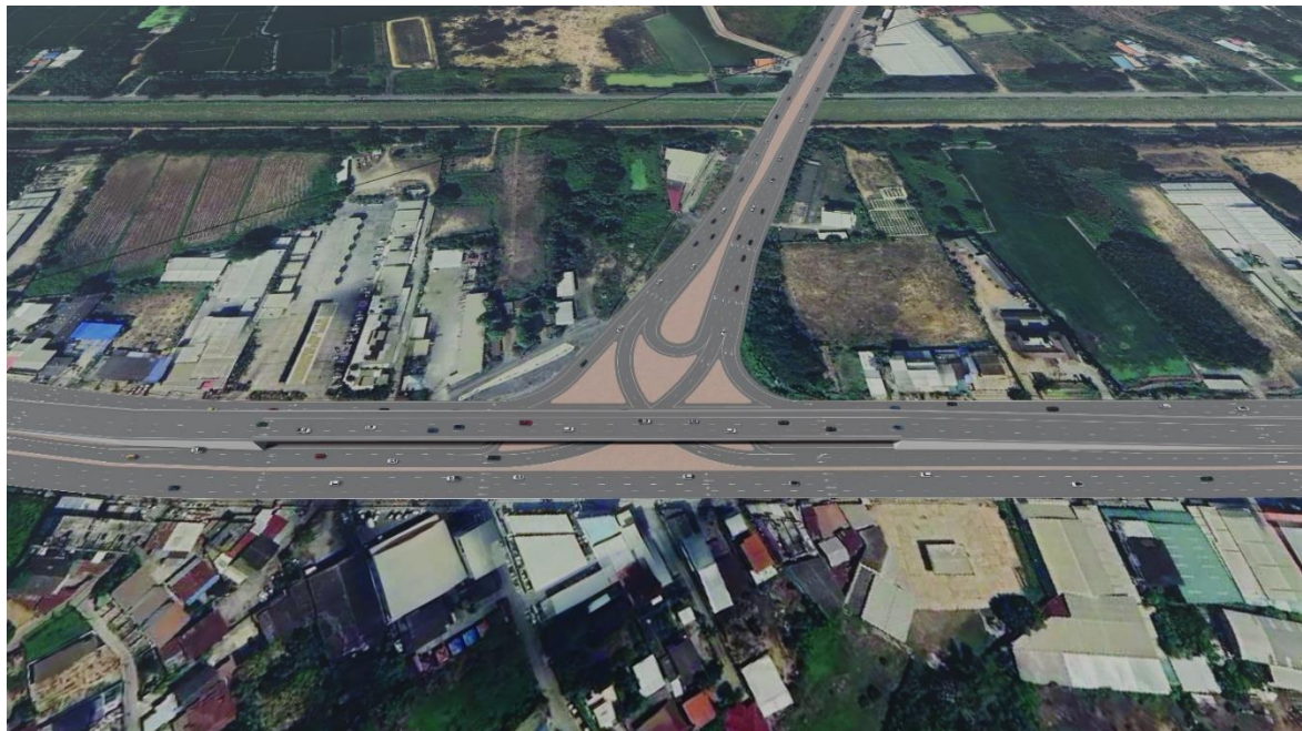
รูปที่ 5.1.3-8 (ต่อ) รูปแบบเบื้องต้นทางเลือกที่ 3 สะพานยกระดับแบบข้ามทางแยกตามแนวทางหลวงหมายเลข 117 (แยกเอ็กซ์เรย์)
