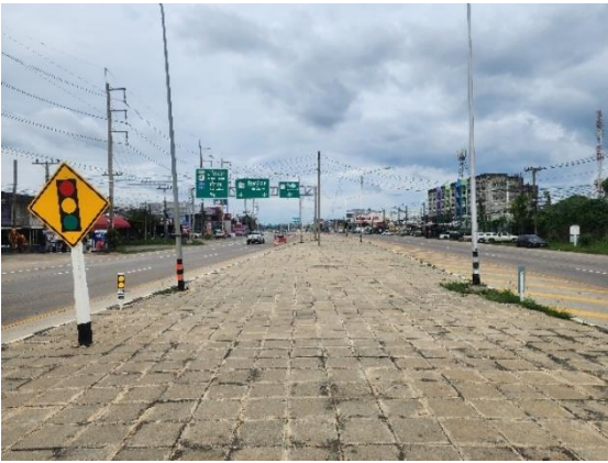
กม.123+500 จุดเริ่มต้นโครงการบน ทล.117
